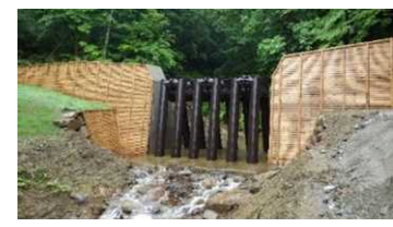
【治山：渓間工(雫石町)】
