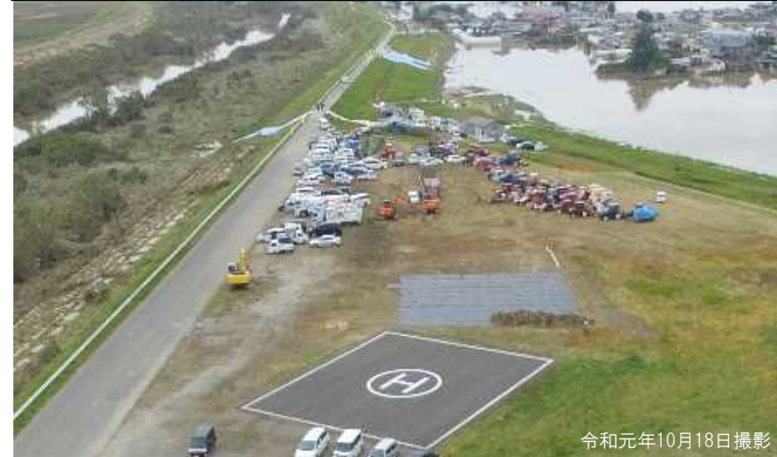
令和元年台風19号での水防災拠点への避難状況 宮城県大崎市(吉田川)
