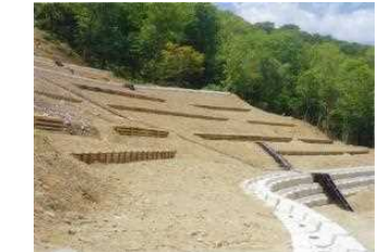
【治山：山腹工(雫石町)】
