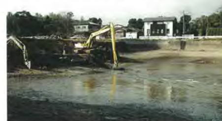
<ため池の浚渫工事>
