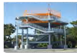
津波避難タワー
