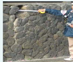
擁壁の危険度調査
