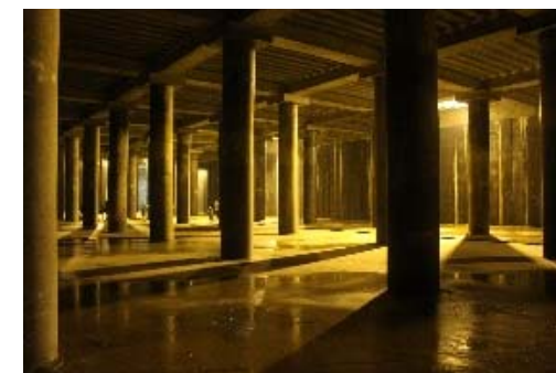
貯留施設の整備
