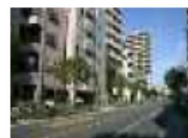
沿道建築物の不燃化 整備後
