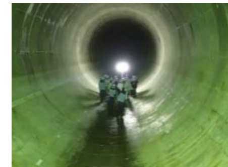
雨水貯留管の整備
