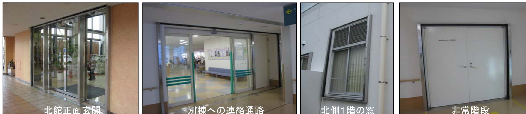
止水板のための角落しとの設置
