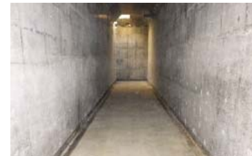
雨水貯留浸透施設のイメージ
