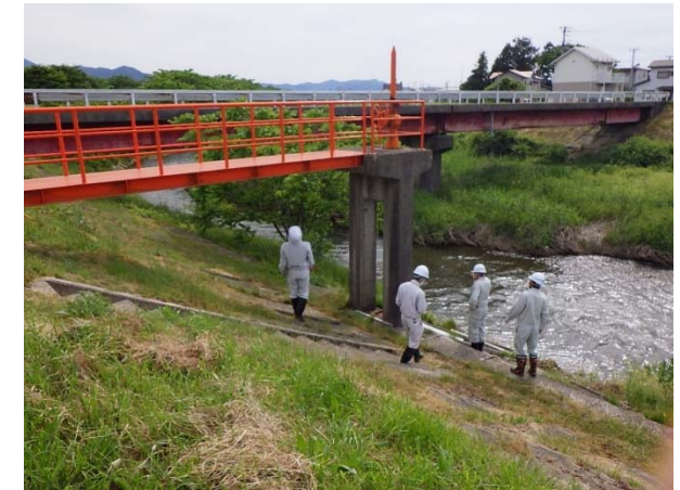
▲道形揚水樋管(赤川土地改良区と合同)
