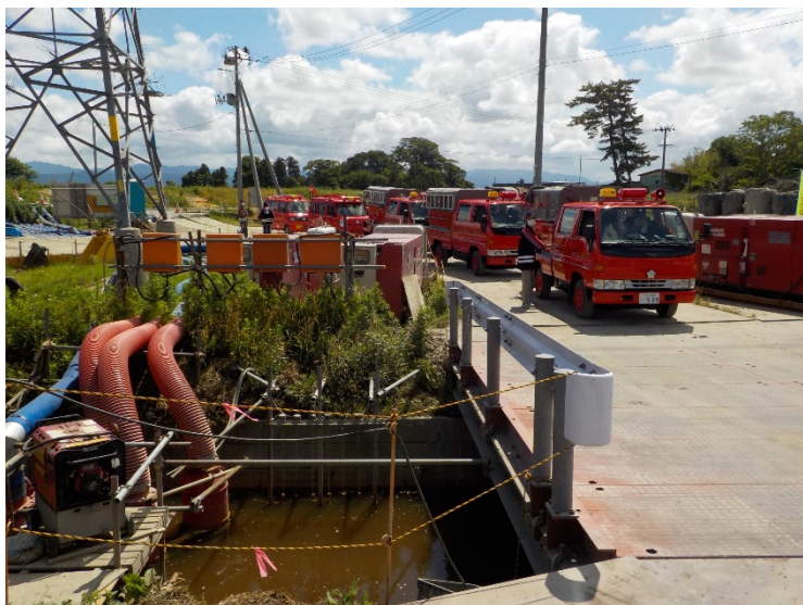
土口地内の二丁排水では、出動時におけるポンプ設置箇所、ホースラインなどの確認をしました。
