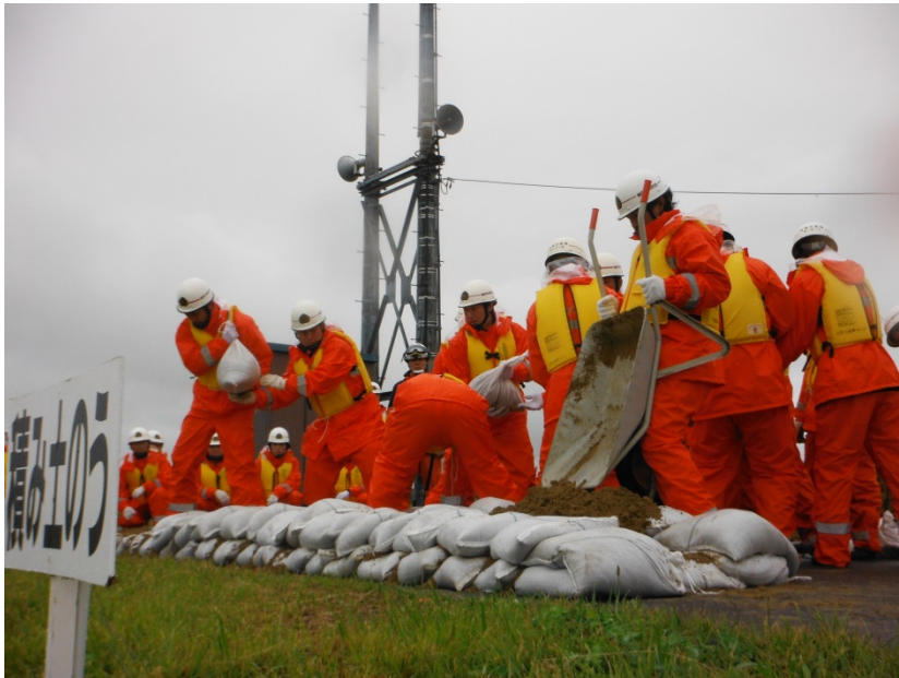
▲積み土のう工法
