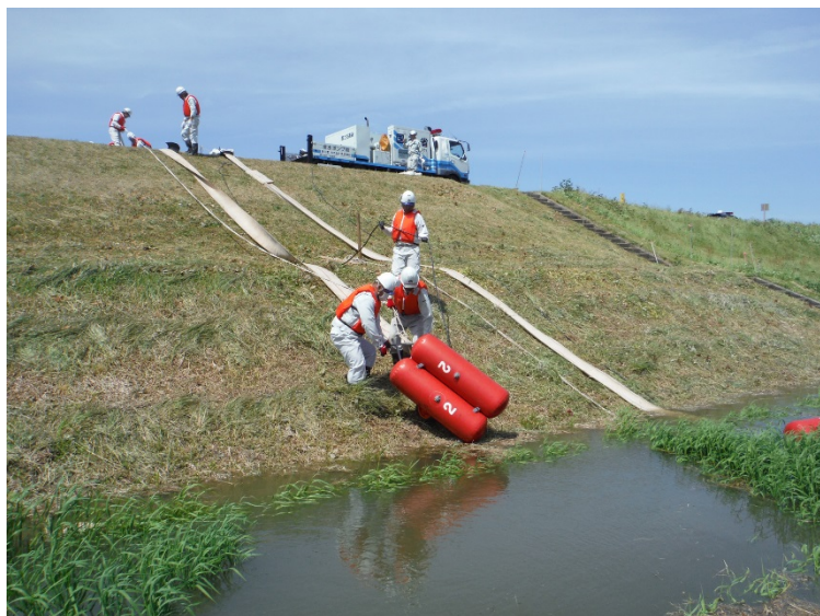
▲川裏側 排水ポンプ設置作業
