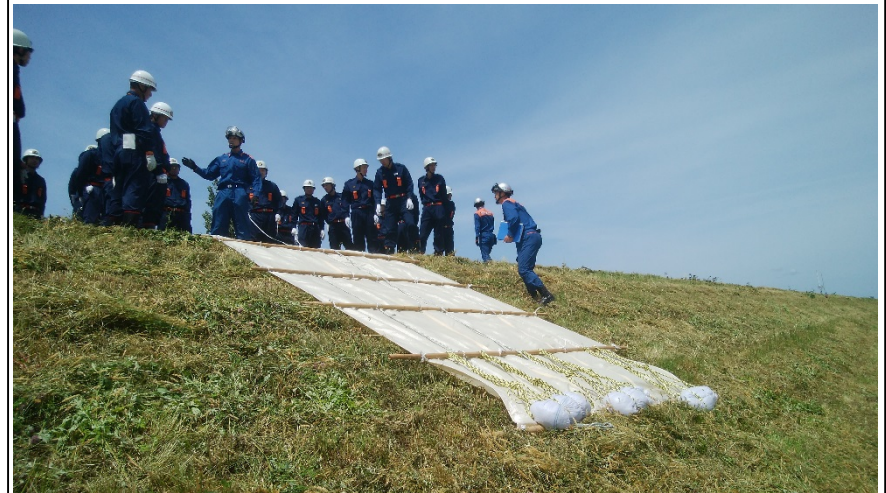
▲シート張り工法の実践の様子
