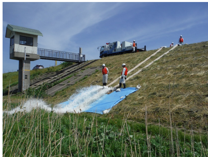
▲川表側 排水状況
