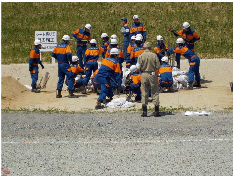
月の輪工の施工
