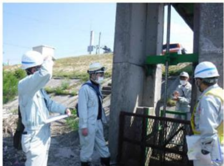
▲下瀬樋管点検(庄内総合支庁と合同)
