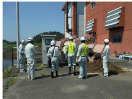
▲袖裏排水機場点検(酒田市と合同)
