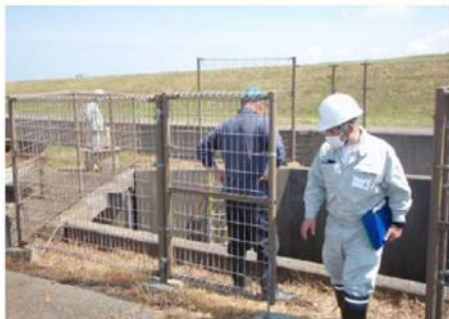
▲新浜広揚水機場（浜中広岡土地改良区と合同）
