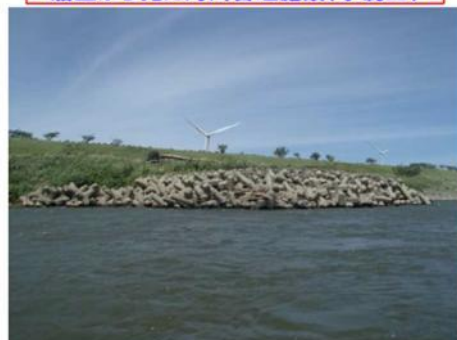
船上から見た河川管理施設(水制工)
