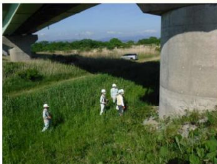
▲最上川白鳥大橋点検(東日本高速道路(株)と合同)
