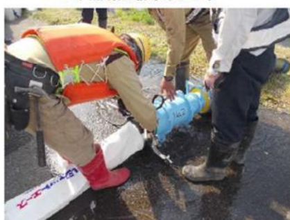
▲排水作業の準備状況
