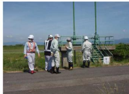
▲道形排水樋門（鶴岡市土木課と合同）
