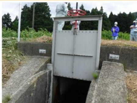
▲根堀沢排水樋管（大町溝土地改良区と合同）
