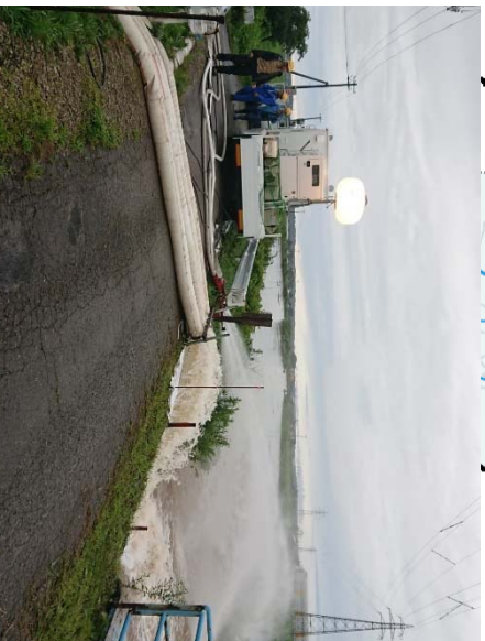
▲三川町土口地内 排水ポンプ車稼働状況
