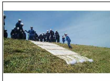
▲シート張り工法の実践の様子
