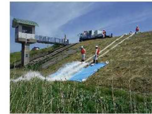
▲川裏側 排水状況
