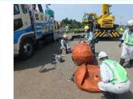
▲浮きの組み立て状況
