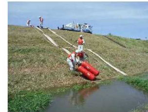
▲川裏側 排水ポンプ設置作業
