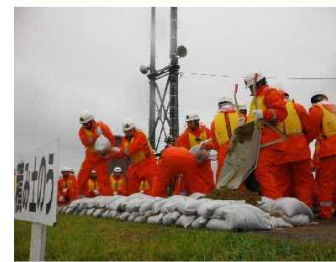
▲積み土のう工法
