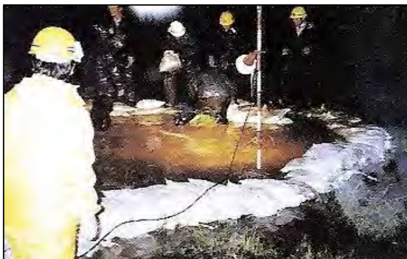
最上川での水防活動(釜段工)
