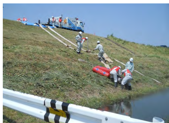
排水ポンプ車設置訓練
