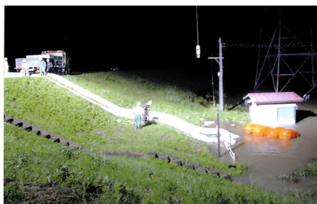
排水ポンプ車による内水排除状況
