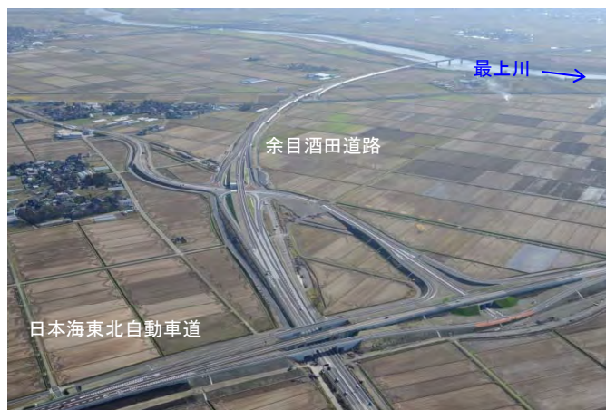
整備が進む国道47号 余目酒田道路
