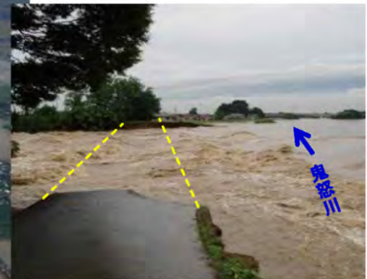
被災状況(拡大写真)
