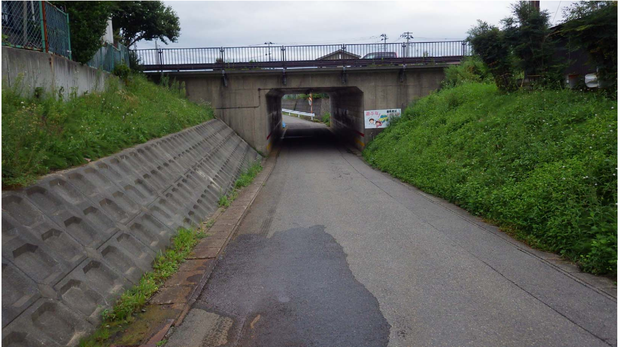
【参考 注意箇所】 いつものようす（国道112号 道形町アンダー）
