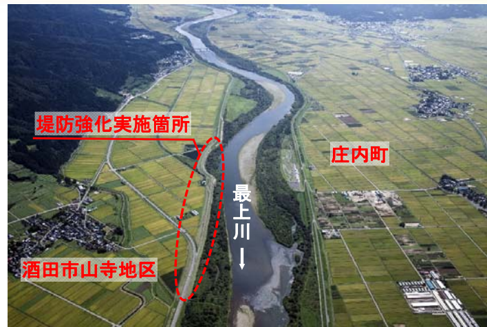
堤防強化実施箇所の航空写真 堤防強化(ていぼうきょうか)
