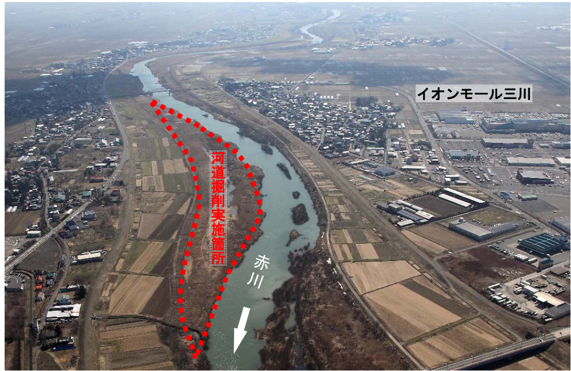
河道掘削実施箇所 航空写真
