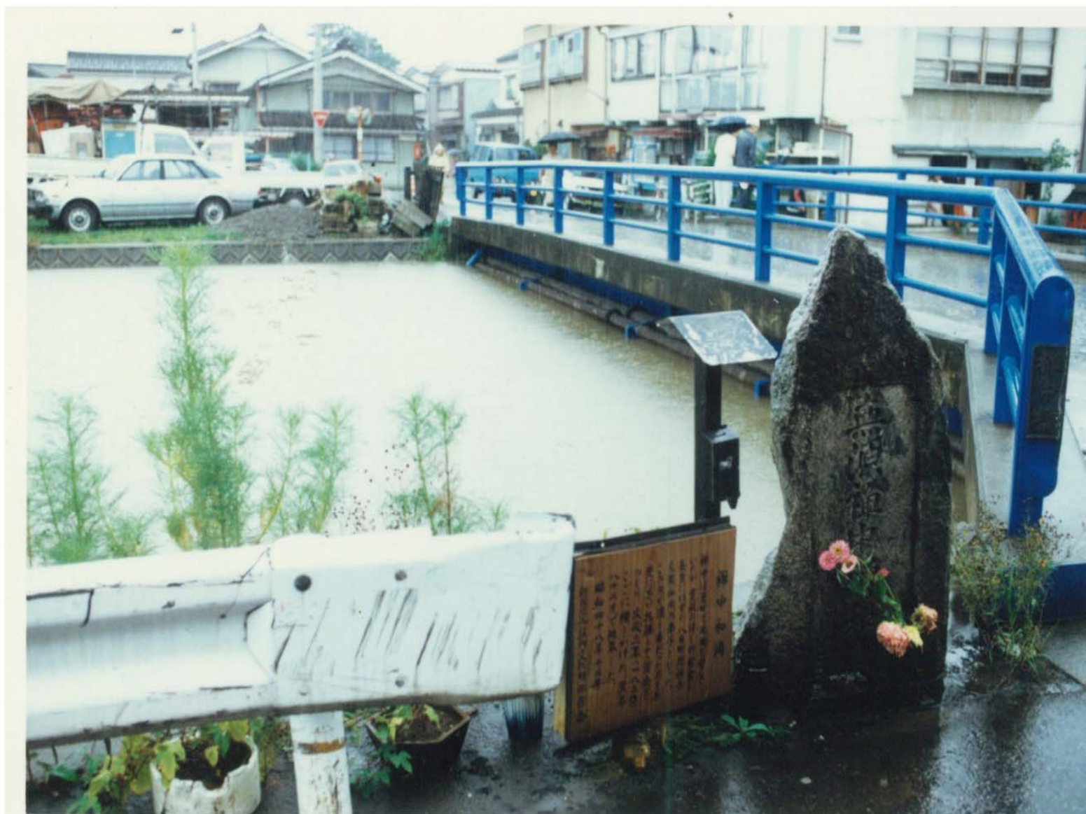
【浸水事例】 1987年(昭和62年)8月洪水(内川:鶴岡市鳥居町)
