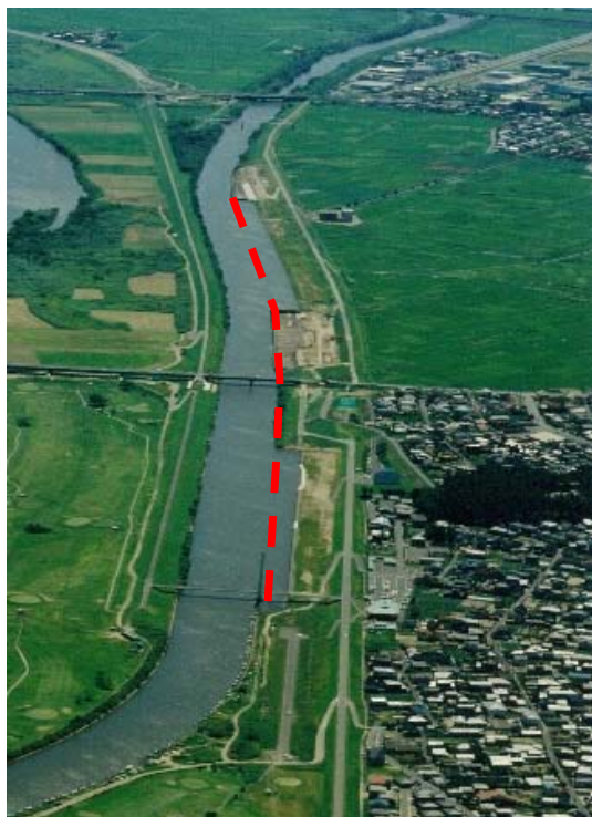
引堤実施中の最上川支川京田川
