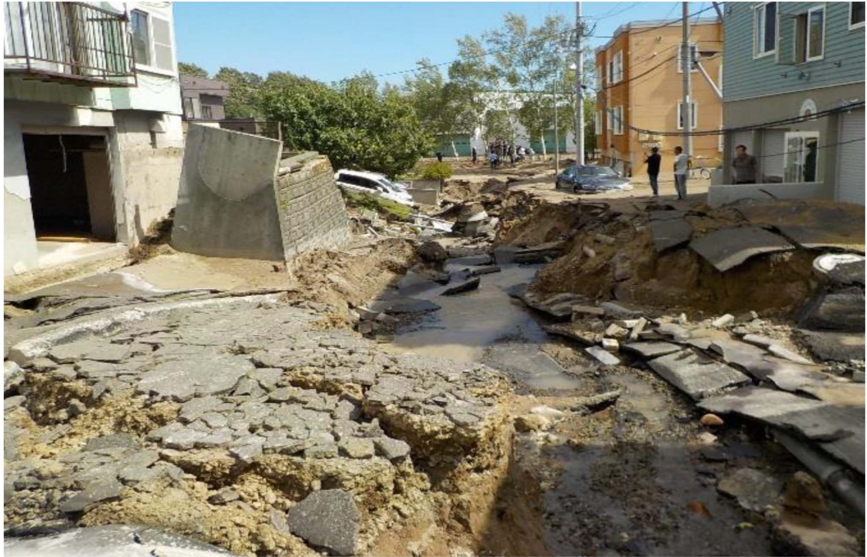
地震「液状化」(北海道札幌市) 2018年(平成30年)9月6日
