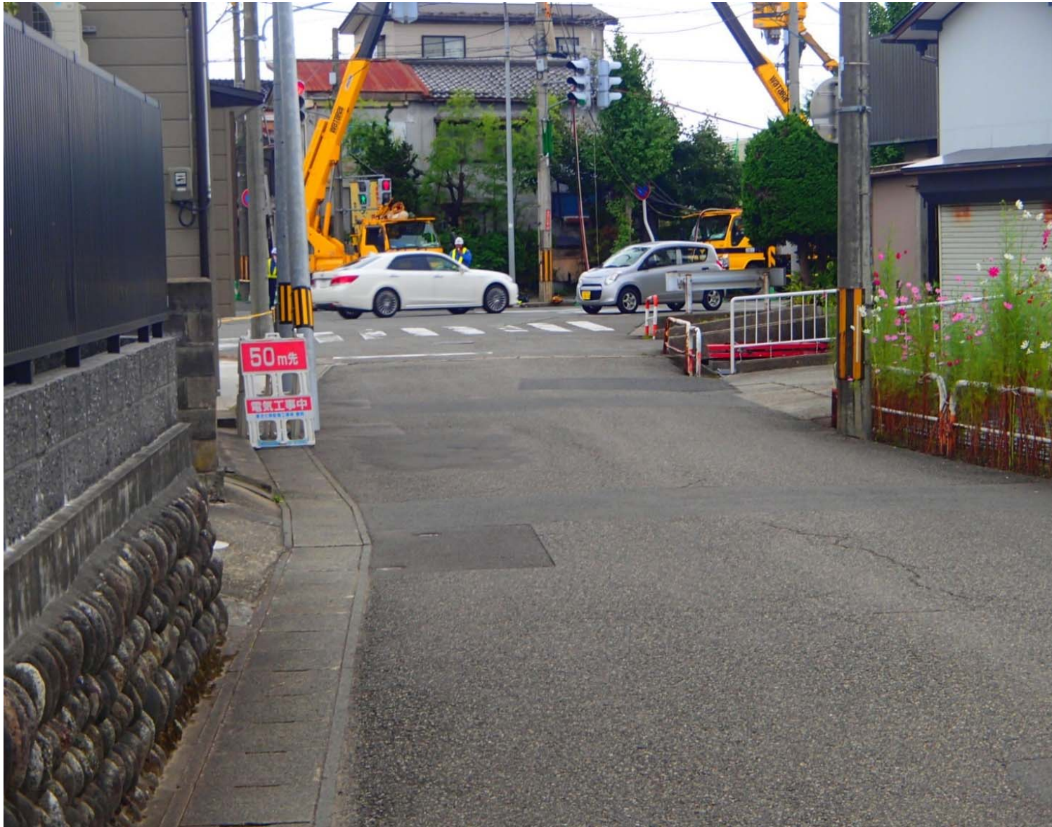
【浸水事例】 いつものようす（鶴岡市日出一丁目）
