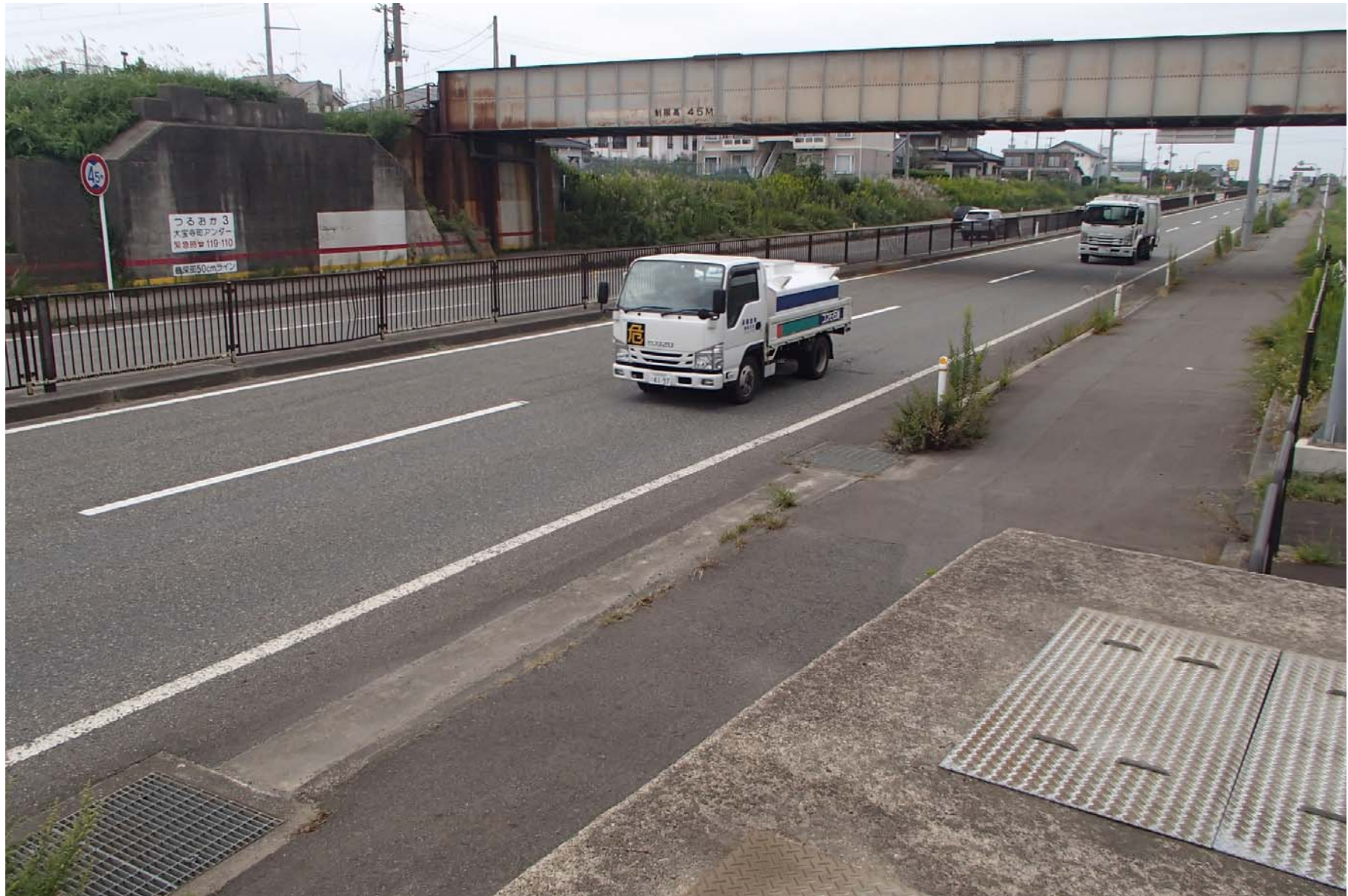
【参考 注意箇所】 いつものようす（国道112号 大宝寺町アンダー）
