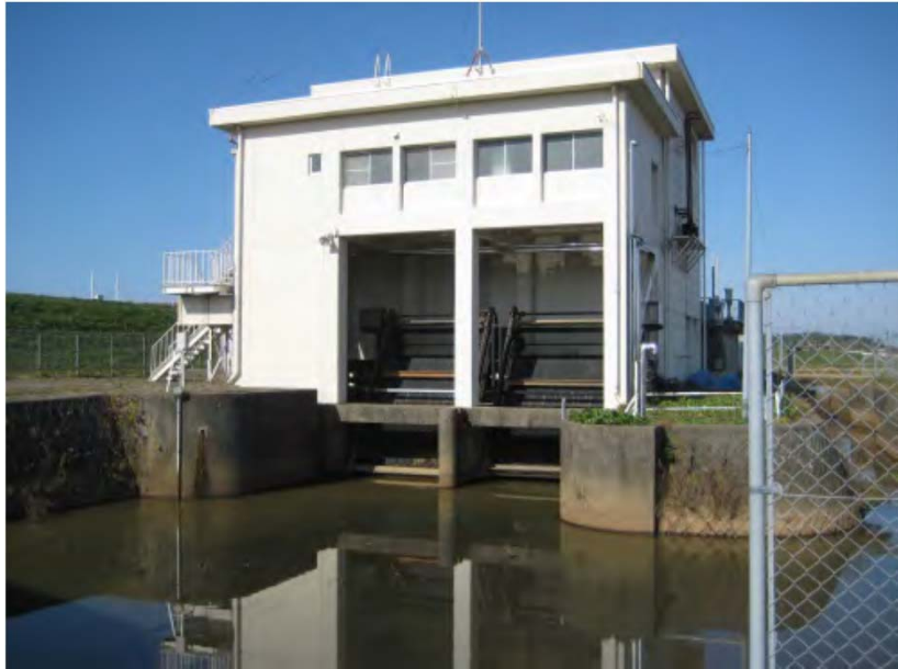
成田排水機場(赤川支川大山川)
