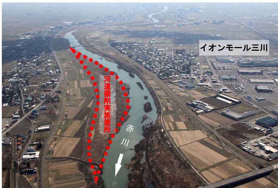
河道掘削実施箇所 航空写真
