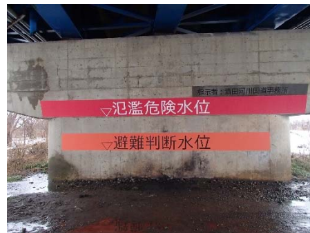
三川橋の水位表示
