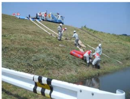
排水ポンプ車による排水訓練
