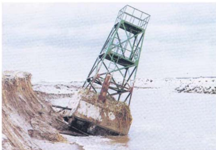
海岸部で監視塔が崩落（平成2年8月 酒田市宮野浦地区）
