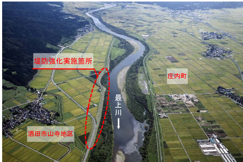
堤防強化実施箇所 航空写真
