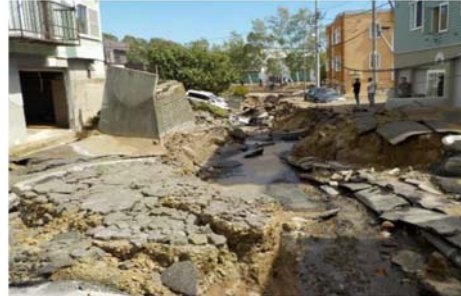
札幌市 液状化による被害 (出典：水害レポート2018 国土交通省)
