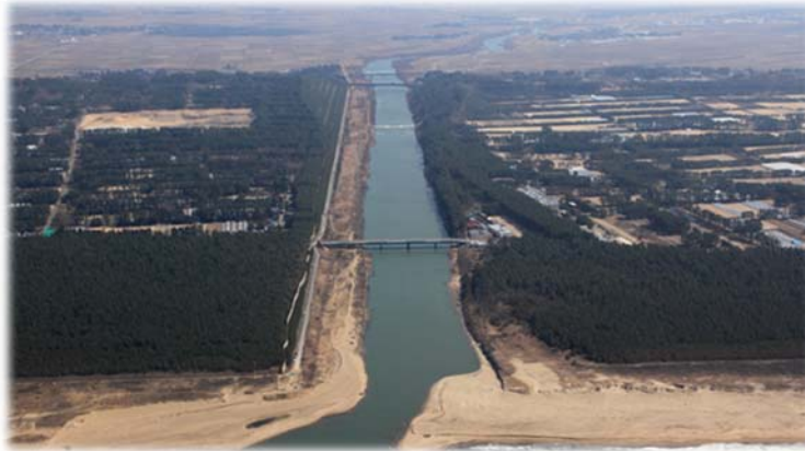
庄内砂丘を開削し、直接日本海へ注ぐ赤川河口
