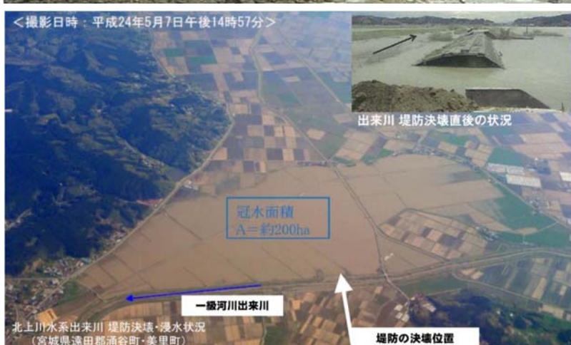
北上川水系出来川の堤防決壊 (出典: 水害レポート 2012)
