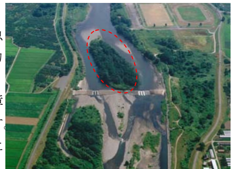
図 3-20 樹木の繁茂状況 (馬渡床止工付近)
