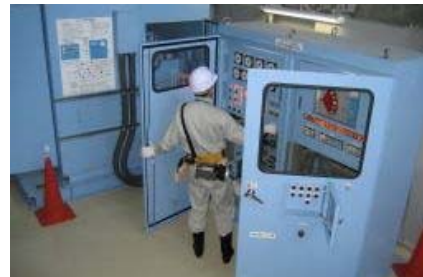
機械設備点検
