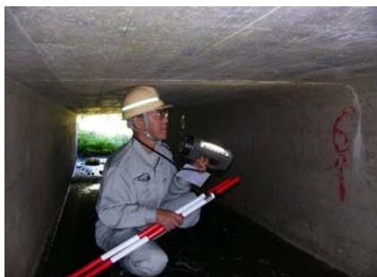
樋門函体内の点検
