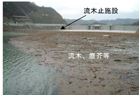
流木止施設による流木や塵芥の捕捉状況
