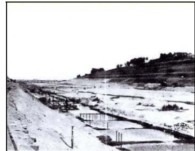
放水路開削工事の様子(昭和8年)
