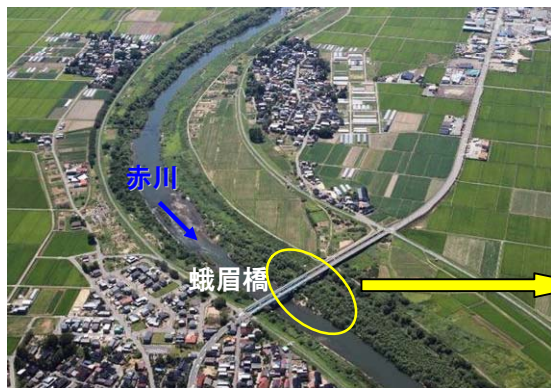
蛾眉橋付近の河道状況 (H23. 8 撮影)
