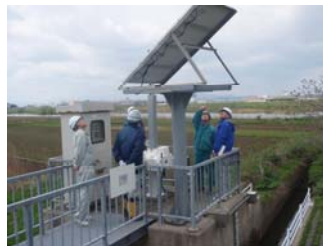
樋門・樋管の点検状況
