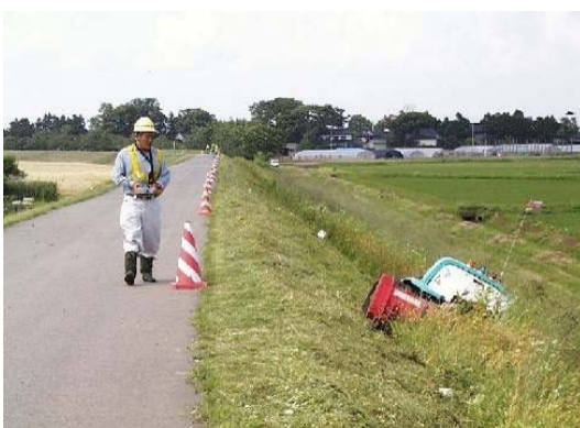
遠隔操作による堤防除草の様子
