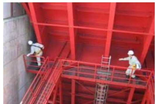
ダムのゲート点検の様子
