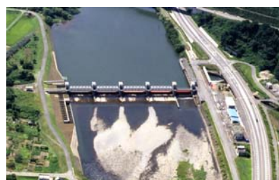
赤川頭首工(昭和44年完成)
