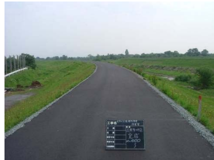
舗装後の状況
