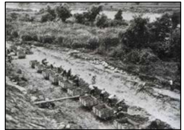
土砂運搬作業の様子(昭和8年)
