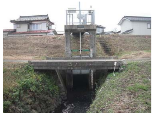
久保田樋管（昭和 15 年完成）
