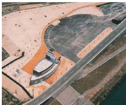
真室川河川防災ステーションの例
