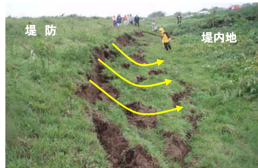
堤防法すべりの事例 (平成19年9月洪水：米代川)
