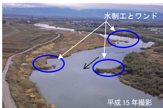
水制工とワンド（4.0k付近）
