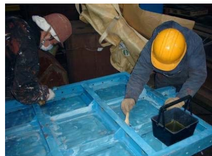
ゲートの補修
