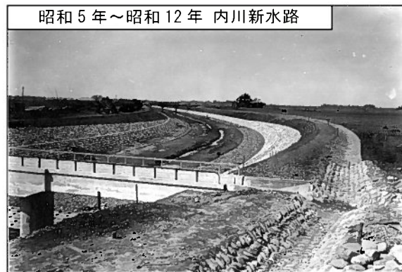
昭和5年～昭和12年 内川新水路
