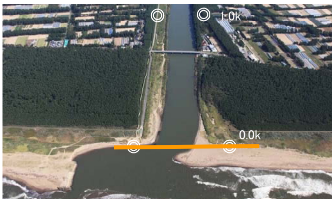
図 3-13 赤川河口部の状況 (22.9 洪水後の状況)
