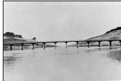
放水路一部通水後の様子(昭和3年)
