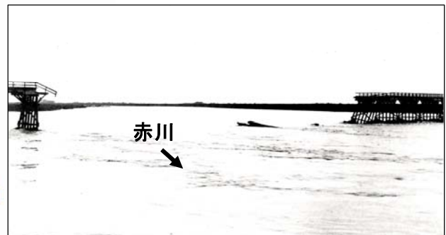
「洪水により流出した菅原橋」 (鶴岡市日出付近)
