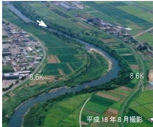
蛇行している下流部の状況（8.6k付近）
