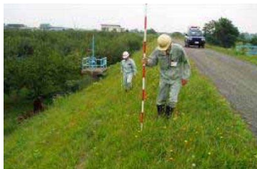
堤防モニタリング状況
