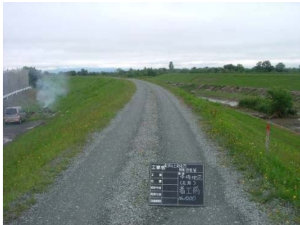
舗装前の状況
