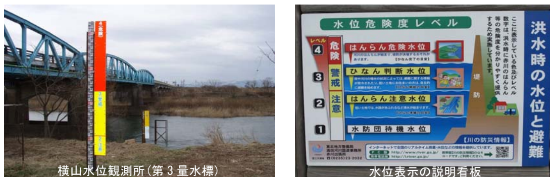
図 3-24 水位危険度をわかりやすく表示した量水標と説明看板
