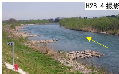
東荒屋地区水制工(24.9k 付近) (H24 完成)
