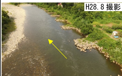
久保地区水制工(24.4k 付近) (H22 完成)
