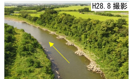
松根地区水制工(27.0k 付近) (H25 完成)
