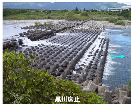
魚類の移動阻害となっている床止
