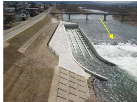
魚道による遡上改善(黒川床止)
