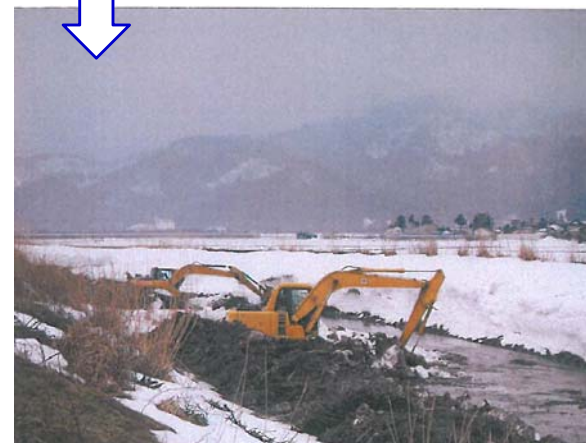
堆積土砂の撤去
