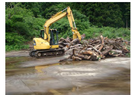
↓ 流木の処理 H26年7月
