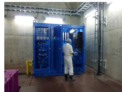
機械設備点検 H26年10月
