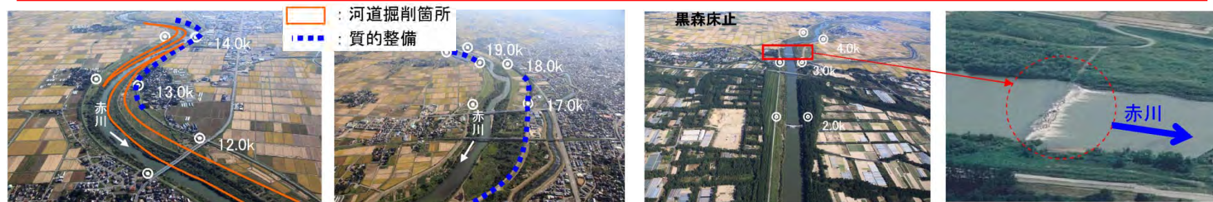
河道掘削及び堤防の質的整備箇所(13k付近)
