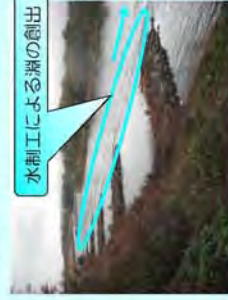
水制工による瀬の再生 (静岡市久保地区水制 H22 完成)
