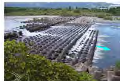
魚類の移動障害となっている床止めの例
