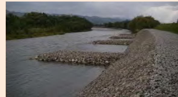
H24完了 東荒屋地区水制
