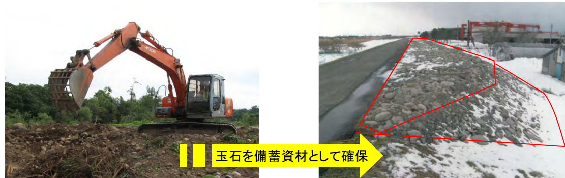
中州掘削土(玉石)の備蓄
