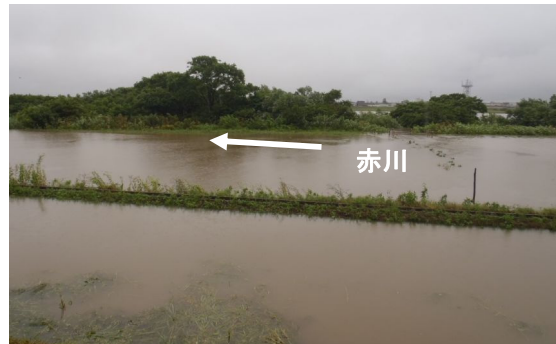
平成23年6月洪水の状況 (三川町上町付近)
