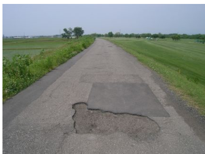
堤防の上面舗装補修前の状況
