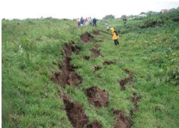
H19.9洪水による裏法面崩壊の例 (米代川左岸7.8km付近)
