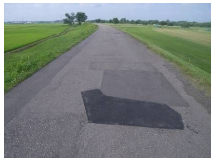
堤防の上面舗装補修後の状況
