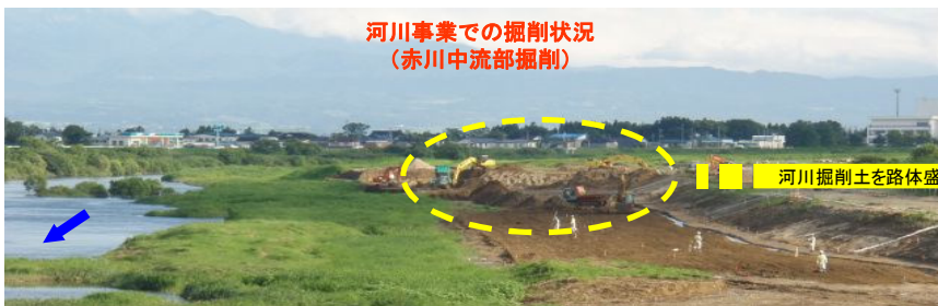
河道掘削の状況
