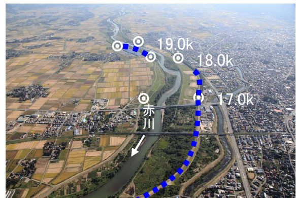
堤防の質的整備箇所 (17k 付近)
