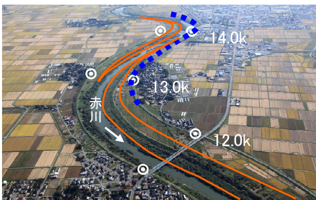
河道掘削及び堤防の質的整備箇所 (13k 付近)
