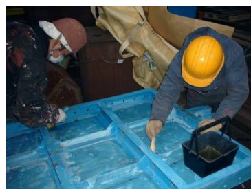
ゲートの補修状況
