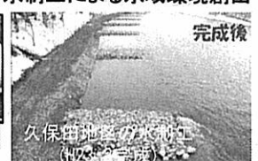
水制工による水域環境創出
