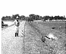
堤防除草の様子
