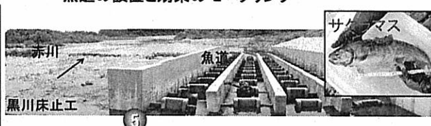
魚道の設置と効果のモニタリング
