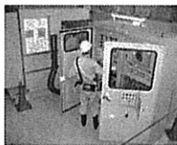
機械設備の点検
