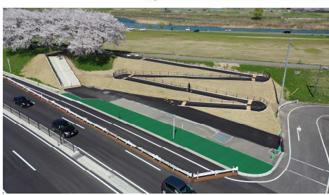
堤防坂路(整備後)
