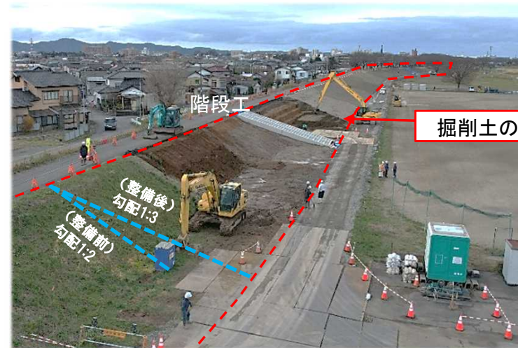
緩傾斜盛土における掘削土の利用
