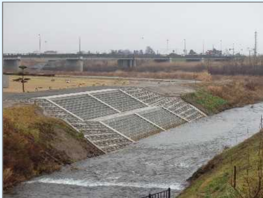
親水護岸(三川町かわまちづくり)
