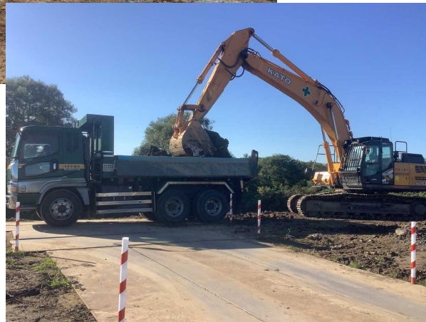
赤川河道掘削工事の掘削状況
