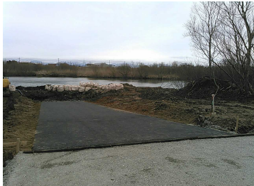
低水坂路(H29整備)
