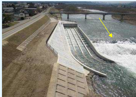
魚道による遡上改善(黒川床止)
