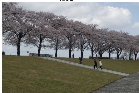
堤防階段(整備後)
