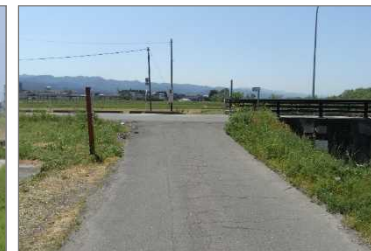
管理用通路(拡幅)
