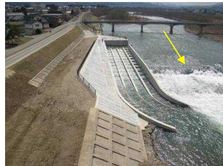
魚道による遡上改善(黒川床止)
