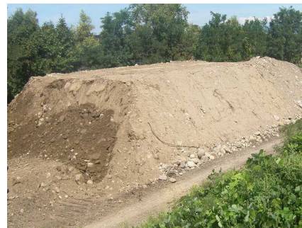
中州の掘削土
