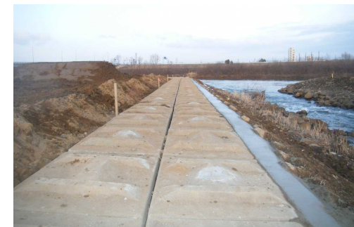
連節ブロックの再利用(護岸)
