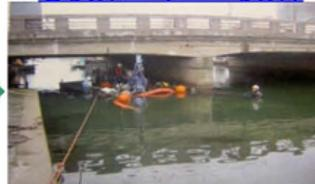
人力、重機によって、水中の土をさらい、橋脚の基礎を表す作業です。
