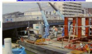
既設橋脚の外側の基礎を表し、基礎上に型枠の代用としてコンクリートの板を取付けする作業です。
