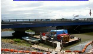
川に台船（作業をする船）を浮かべ、コンクリート板を取り付ける準備作業です。
