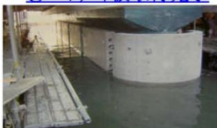
コンクリート板取付後、板の内側をコンクリートを流し込み、橋脚を太くします。
