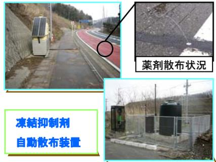
凍結抑制剤自動散布装置
