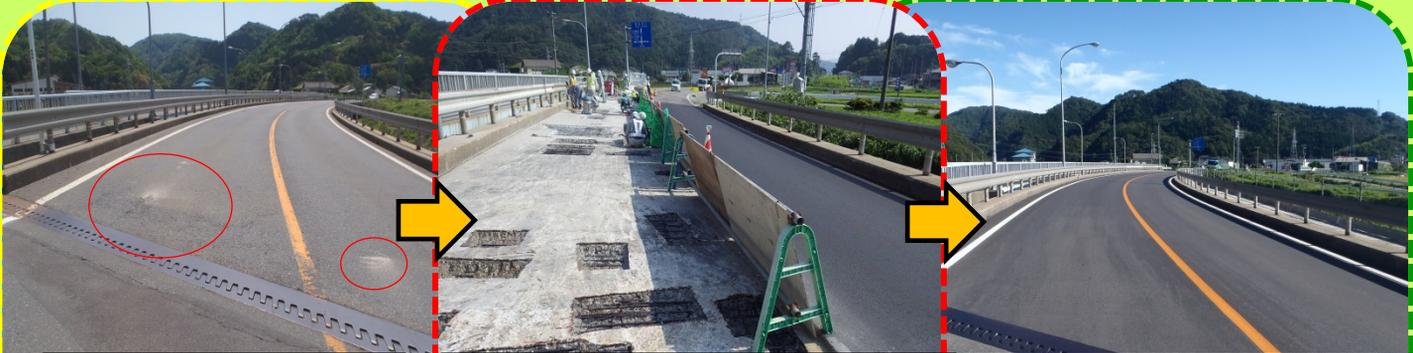
コンクリートの橋が傷んできているため、橋の表面に土砂が吹き出している状況。
