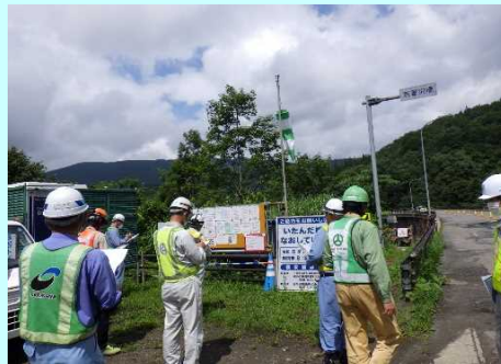
岩菅沢橋工事現場
