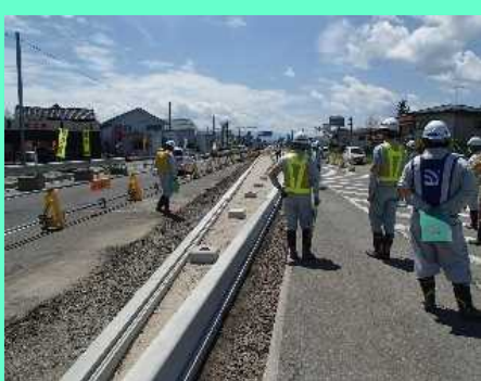
工事の安全パトロール
