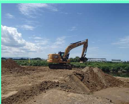
工事の安全パトロール
