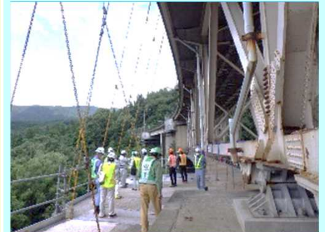
岩菅沢橋工事現場
