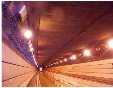
天井板設置状況(月山第二)
