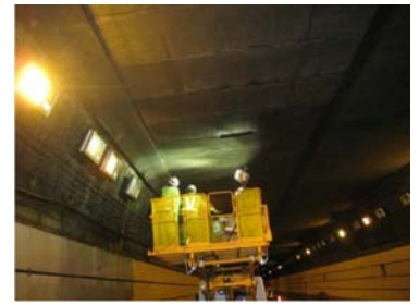
天井板点検状況(月山第二)
