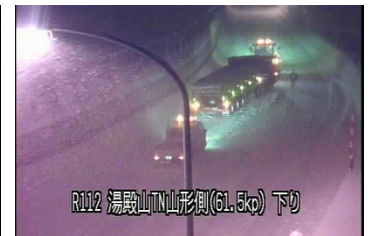
除雪機械による排除作業
