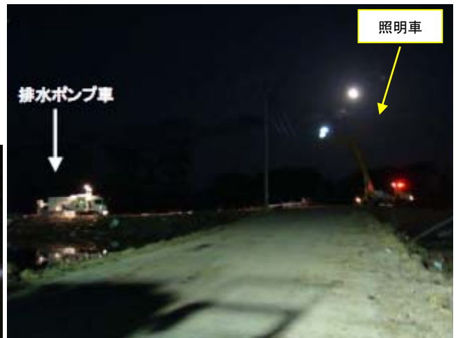
夜間の排水作業状況（名取地区）
