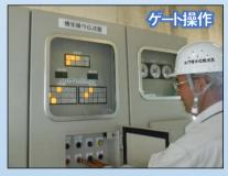
→ 大雨などにより川の水位が高くなったときは、川の水が逆流 して住宅地側に流れ込まないように、ゲート(門扉)を閉めます。
