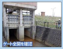
⇒ 川の水位が低くなり、住宅地側へ逆流の心配が無くなったら ゲート(門扉)を開け、宅地側の水を川に流します。
