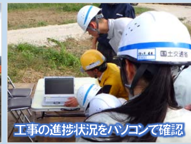
「道の駅 鳥海」の移転建設現場
