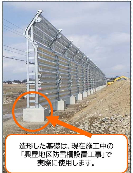
造形した基礎は、現在施工中の「興屋地区防雪柵設置工事」で実際に使用します。
