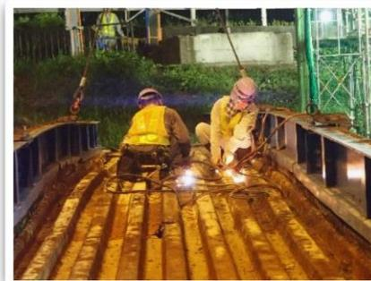
▲ 運搬するために橋桁を切断して
