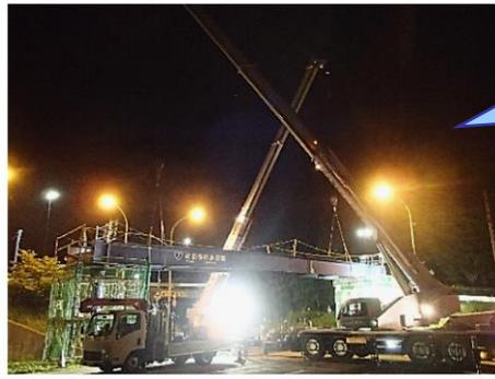
▲ 老朽化した歩道橋を撤去している様子
