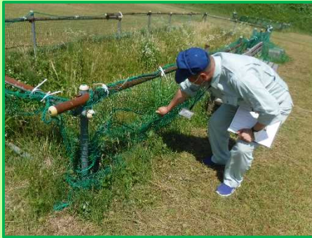
点検の様子(清川河川公園)
