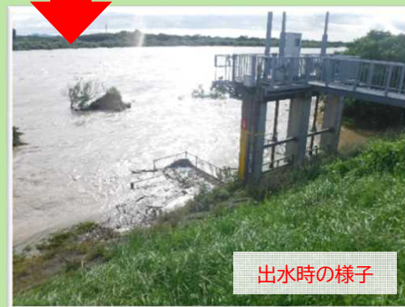
平常時の二段割樋門付近
