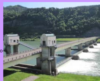
起立中のさみだれ大堰
