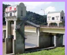
船通し閘門 ゲートを操作し水位を調整してからの航行となります
