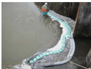
油の拡散を防ぐ為材料フェスを設置し吸着マットを投入している様子
