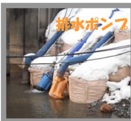
②作業しやすいように囲んだ中の水を抜く
