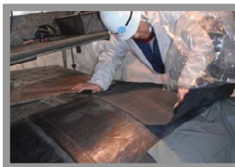
④異常のあった表面ゴムを剥がし新しいゴムを貼り付ける
