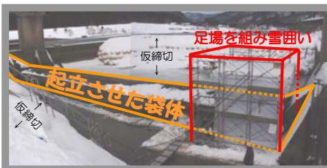
③雪、風を防ぐため、足場を組み補修箇所を覆う雪囲いを設置
