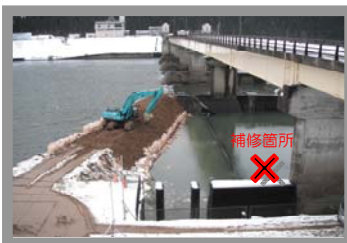
①補修箇所のゲートを土のうで囲み、仮締切を作る
