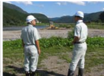
清川河道掘削の工事現場にて。工事概要の説明を受ける。
