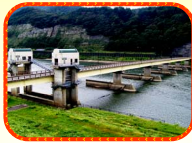
現在(堰倒伏後)
