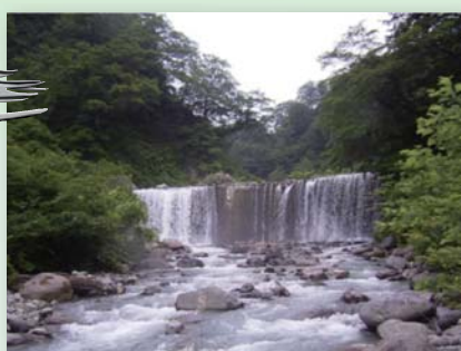
濁沢第1砂防堰堤
