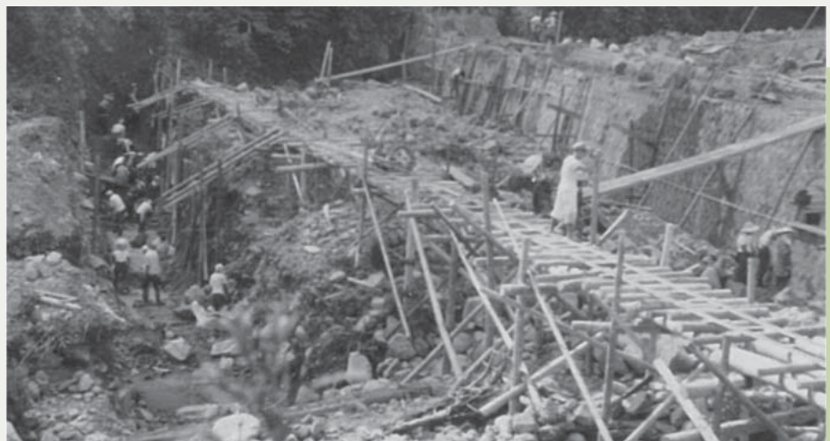
昭和 28 年頃の瀬場砂防堰堤の工事の様子
