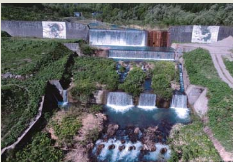
「砂防堰堤のジオラマ」 五十嵐 貞一 さん (山形県鶴岡市)
