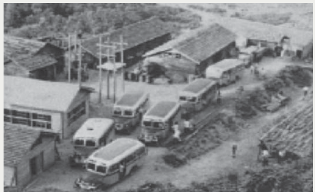
建設に従事された方々の送迎状況
