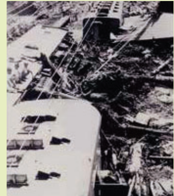
列車を襲った土石流(現在はJR奥羽本線)
