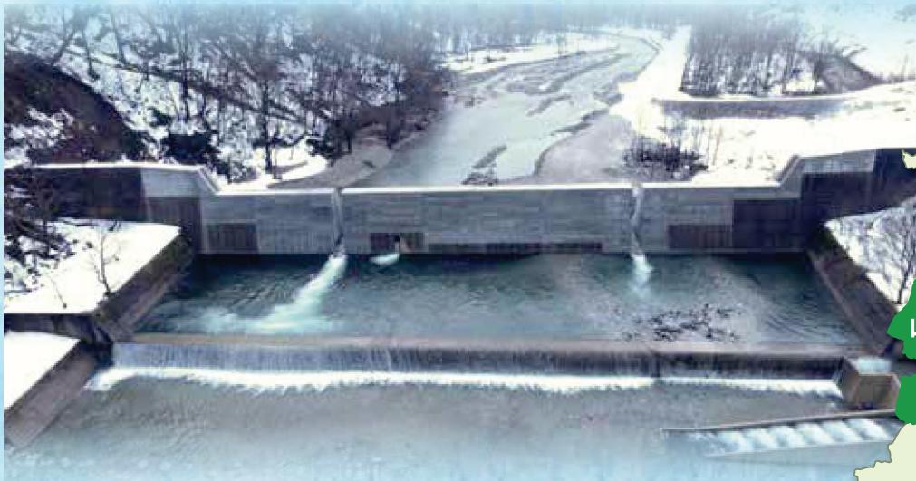
東大鳥川砂防堰堤
