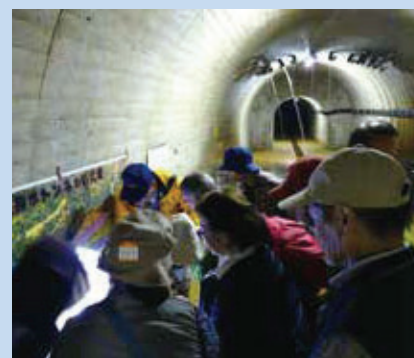
豊牧地すべり排水トンネル
