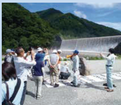
六測砂防堰堤
