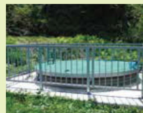
集水井工 豊牧3号集水井
