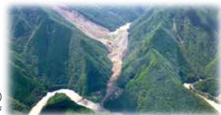
天然ダム(奈良県) 出典:近畿地方整備局ホームページ
