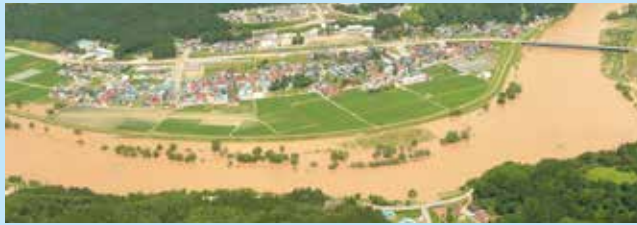
平成25年7月の洪水時、堤防により守られた市街地と田畑（大蔵村清水地区）
