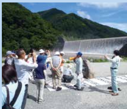
六洲砂防堰堤
