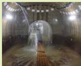
横道沢・排水トンネル工
