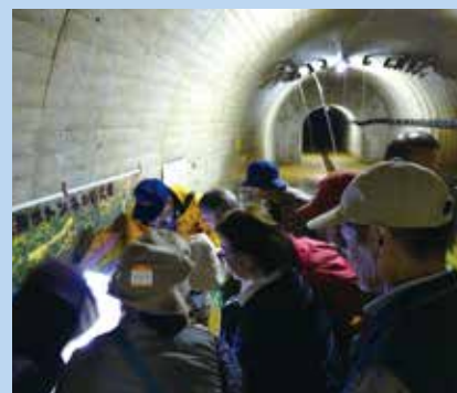
豊牧地すべり排水トンネル
