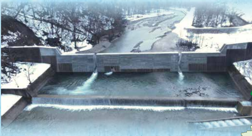
東大鳥川砂防堰堤
