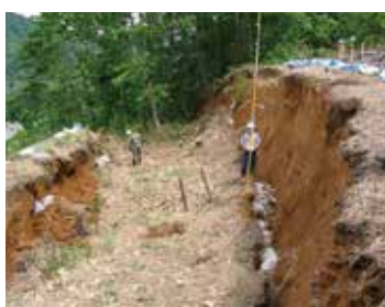
被災状況(H16田麦俣地すべり)
