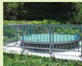
集水井工 豊牧3号集水井
