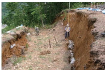
被災状況(H16田麦俣地すべり)
