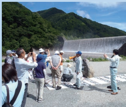
六瀬砂防堰堤
