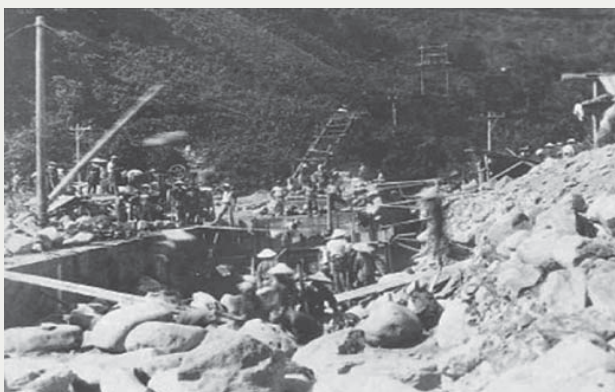
昭和 24 年頃の六漕砂防堰堤の工事の様子
