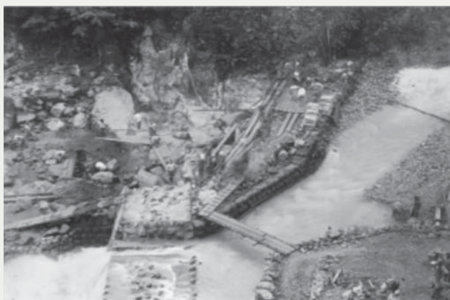
昭和17年頃の濁沢第3砂防堰堤の工事の様子
