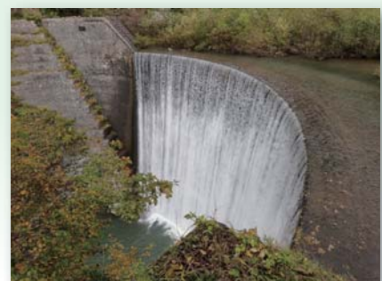
赤沢第1砂防堰堤
