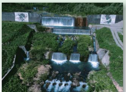
龍神が描かれた玉川第6砂防堰堤
