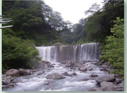
濁沢第1砂防堰堤
