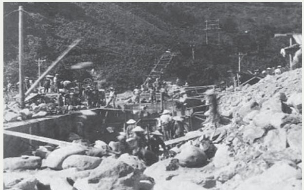
昭和 24 年頃の六淵砂防堰堤の工事の様子
