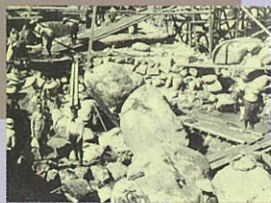
▲濁沢第2ダム工事中
