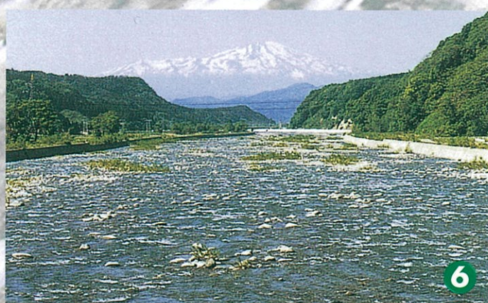
■立谷沢川溪流保全工全景（滝の沢橋上流より下流を望む）
