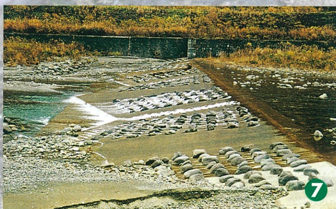
■床固工／斜路形式全面魚道
