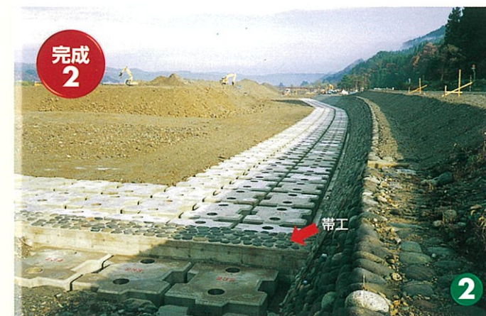
■護岸工（もたれ型・玉石張・5分勾配・帯工）
