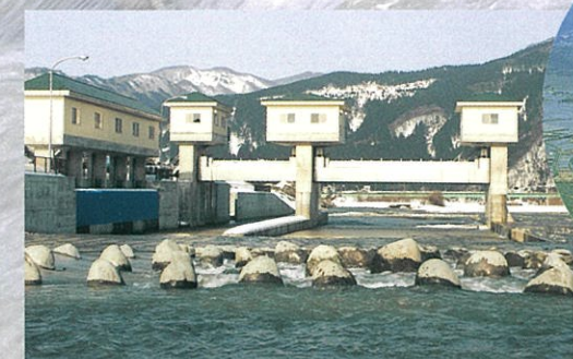
■北楯大堰頭首工（平成11年改築）
