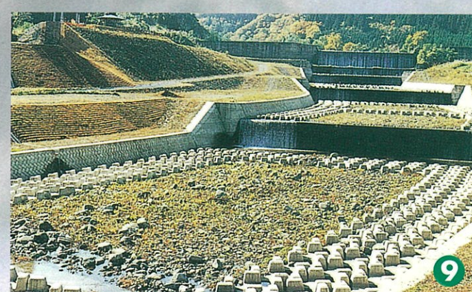
■玉川溪流保全工
