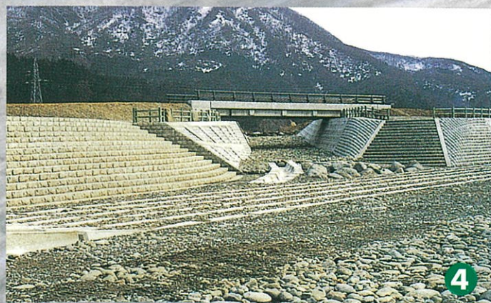
■水とふれあう親水護岸（自然石を利用した護岸）／木ノ沢橋右岸上流
